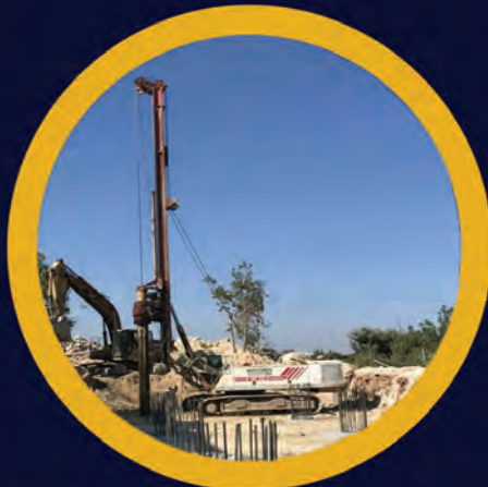
Boğaztepe - Villa Temel Altı Kazık
